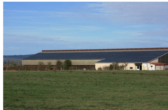
Hangar recouvert de panneaux photovoltaïques
